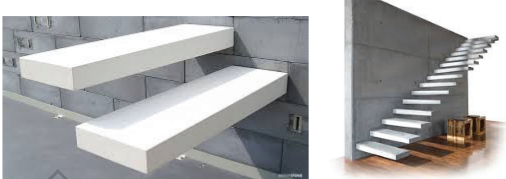
රූපය 1.49 (a) - කැන්ටි ලීවර් ආකාරයට නිර්මාණය කරන ලද තරප්පු පෙළක්
