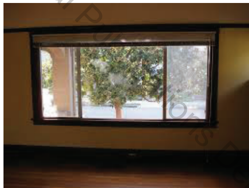
රූපය 1.112 සම්පූර්ණ වර්ගඵලයෙන් අඩක් විවර කළ හැකි ජනේලයක්
