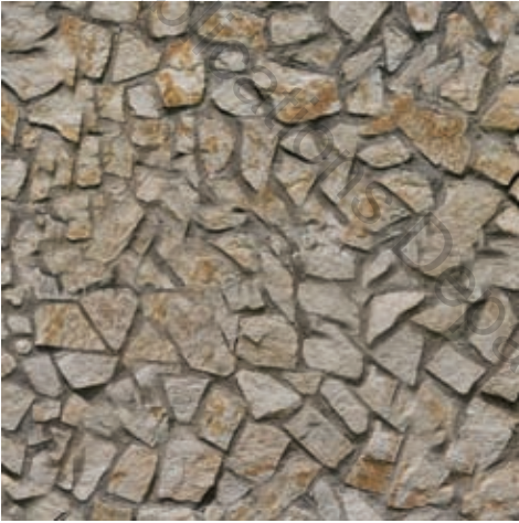
රූපය 1.36 - රළුගල් උළුවම (Rubble masonry)
