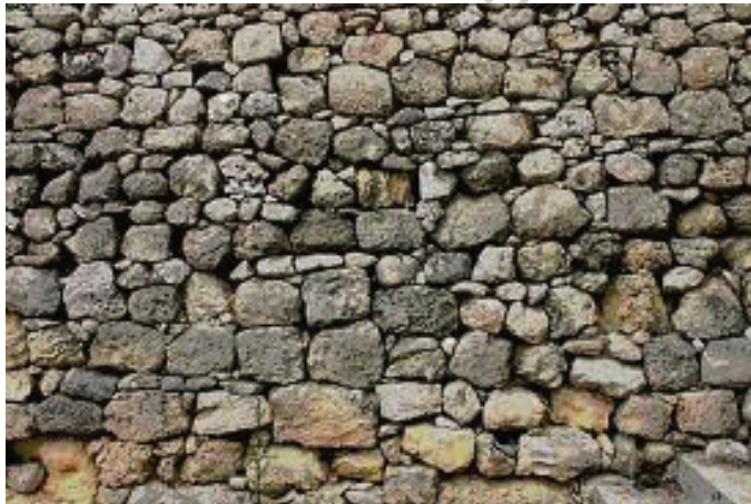
රූපය 1.35 - රළුගල් බැම් බැඳීම (Rubble / Stone Masonry)
