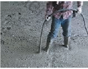
c සුසංහසනය කරන අයුරු (Concrete Compaction Machines)
