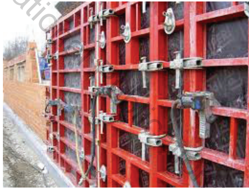
රූපය 1.52 - බාහිර කම්පකයක් හැඩයමට සම්බන්ධ කරන ආකාරය
